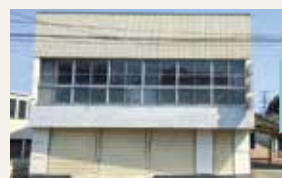
改修前(空き店舗)
