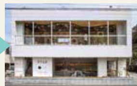
改修後(地域コミュニティ施設)
