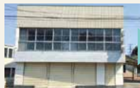
改修前(空き店舗)
