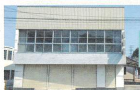
改修前(空き店舗)
